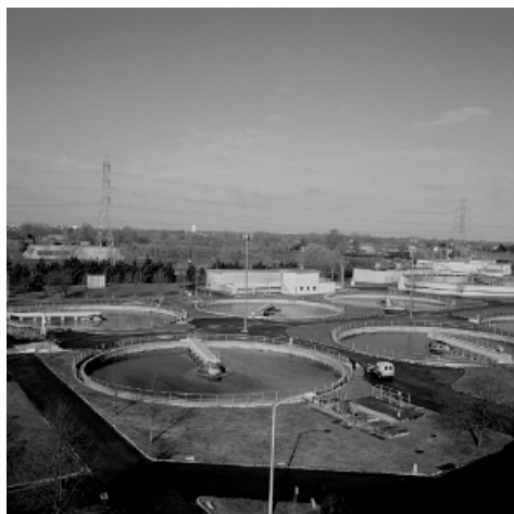
Estación de tratamiento de aguas
